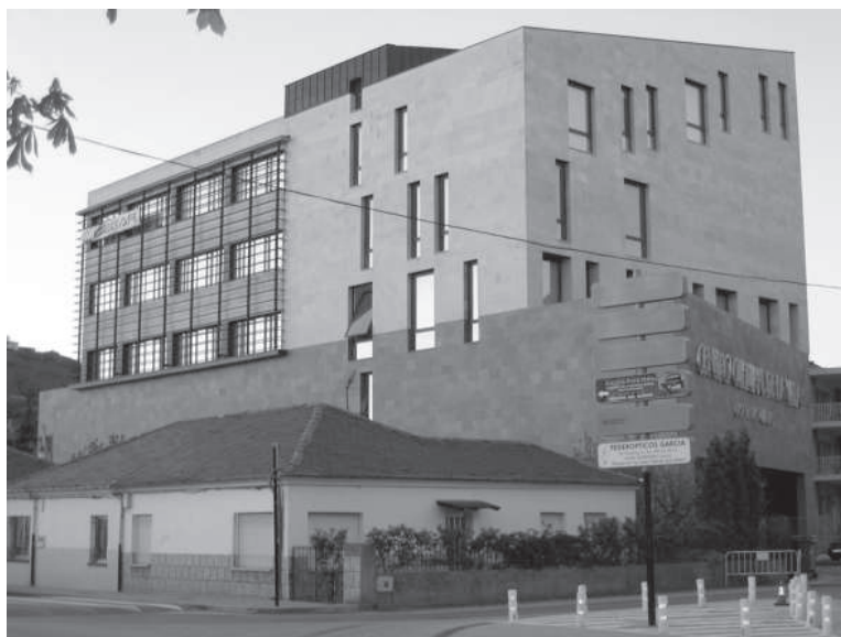
Casa de la Cultura. Bembibre
